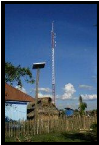
Figura 7.- Paneles solares que alimentan un PS.
