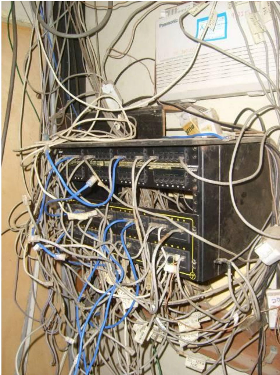
Estado de la antigua red del HAY
