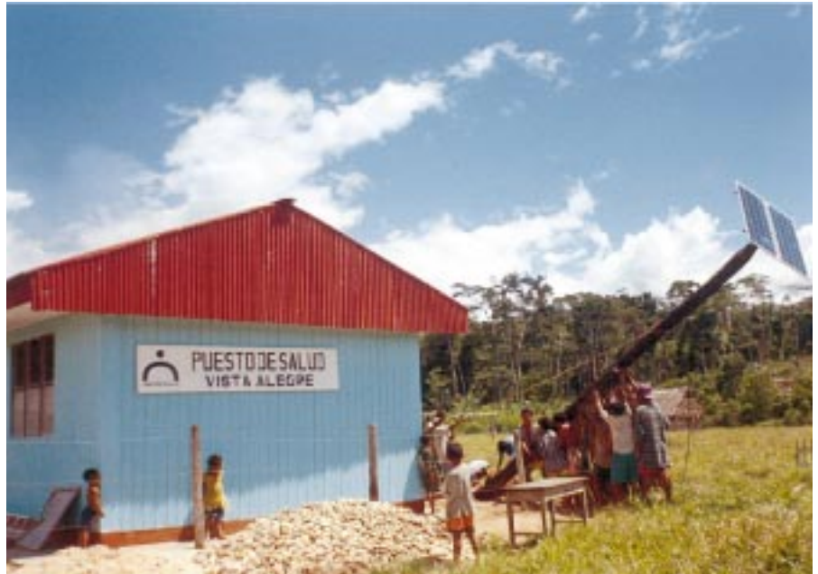
Instalación de módulo solar para puesto de salud (foto: Cesar Córdova)
